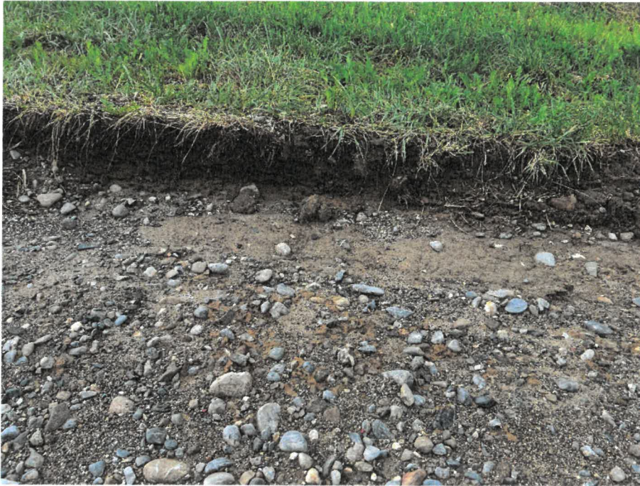
Bild 3: Detailansicht von der Sohle des ehem. Straßenkörpers und dem Anschnitt des gewachsenen Bodens, Blick Richtung Osten (11.09.2024)
