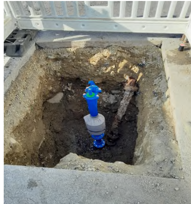
Neuer Unterflurhydrant mit Sickerpackung
