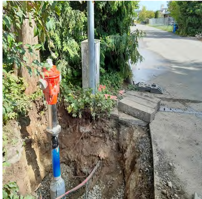
Neuer Überflurhydrant eingebaut
