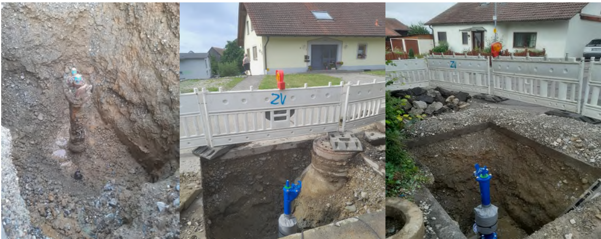
Defekter Hydrant vor Ausbau
