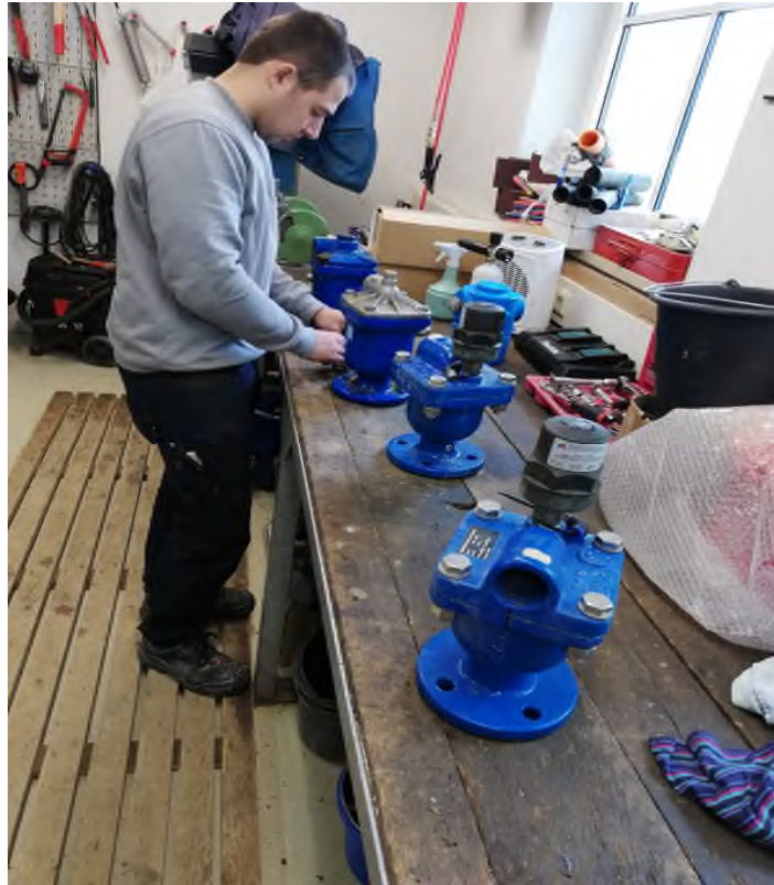
Wartung der Be- und Entlüfter in der Werkstatt
